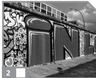
2 die Reste der Berliner Mauer
